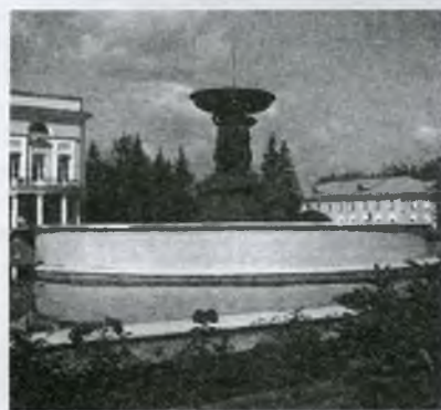
Рис. 23. Никольский водозаборный фонтан самотечного Мытищинского водопровода с Лубянской площади сейчас украшает территорию перед зданием Президиума РАН.
