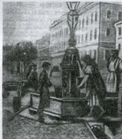
Рис. 22. Фонтан самотечного Мытищинского водопровода на Неглинной улице (с гравюры начала XIX в.).
