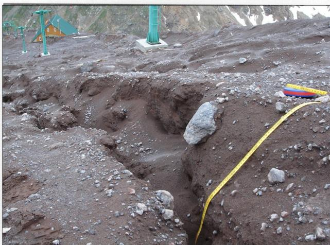
Рис. 5. Термоэрозионные промоины на трассе
