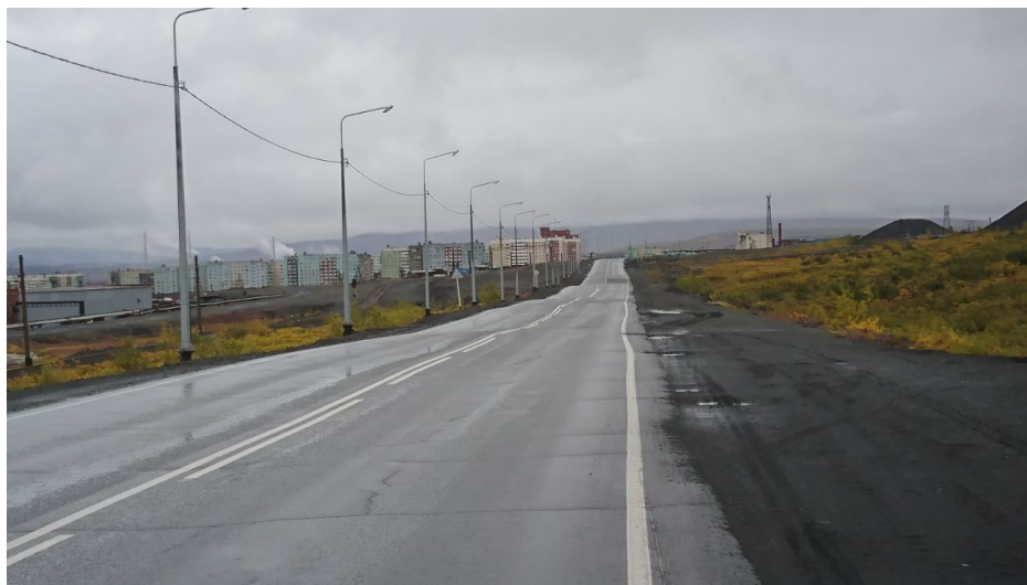
Рис. 5. Волнообразные равномерно распределенные деформации полотна трассы «Норильск–Алыкель» при вытаивании повторно-жильных льдов, объезд г. Кайеркан. 5.09.2017
