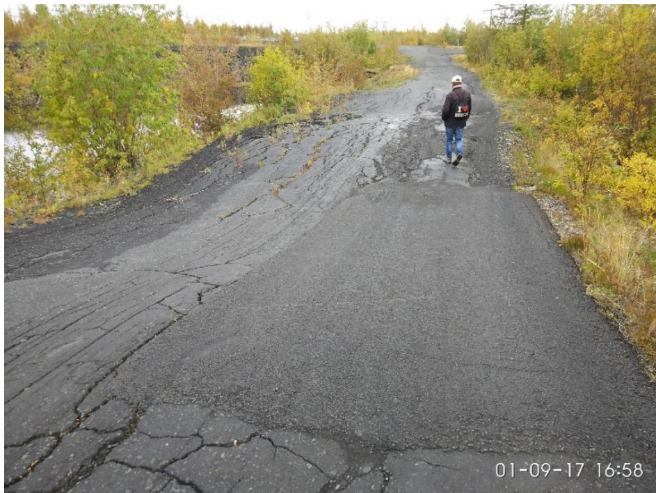
Рис. 8. Деформации дороги к рекреационному комплексу «Валёк» при вытаивании подземных льдов в основании и развитии термокарста на примыкающих участках
