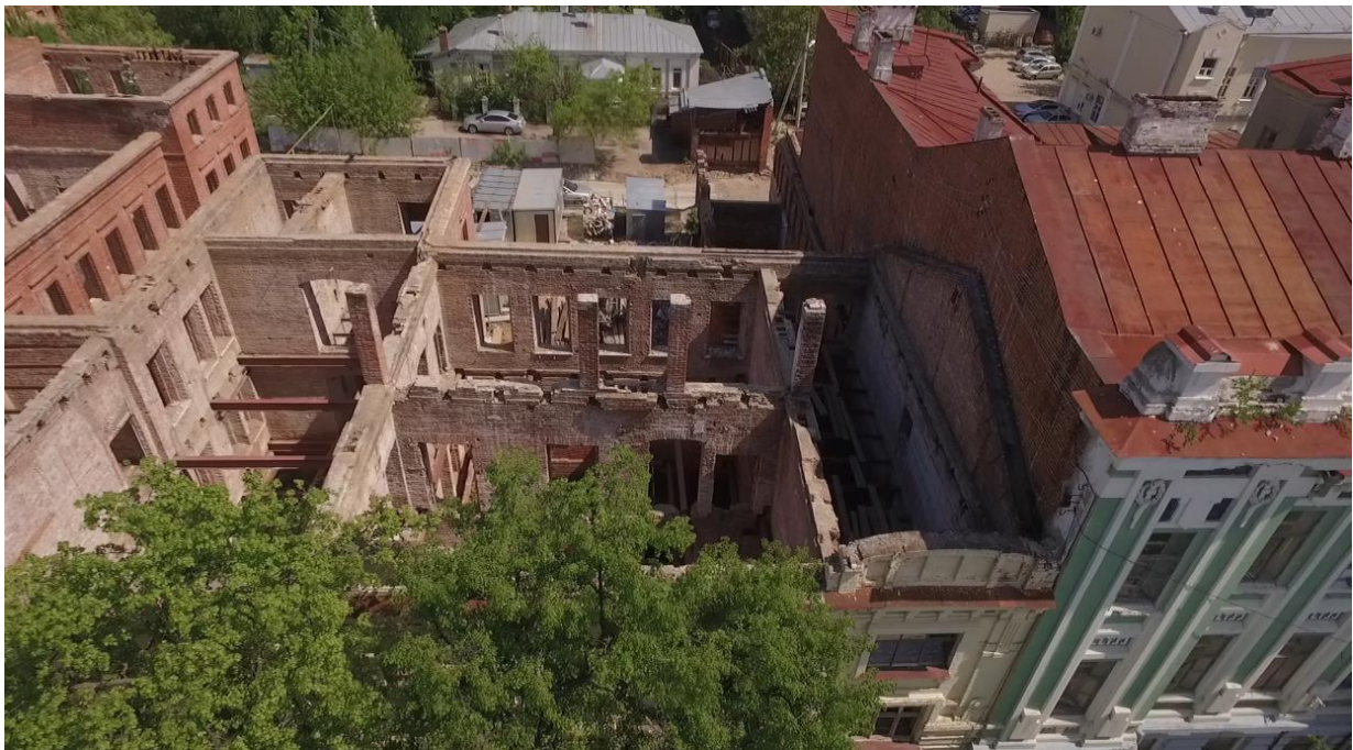
Рис. 2. Вид прилегающих объектов. Существующее аварийное здание
