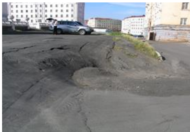
Рис. 8. Осадки и просадки грунтов на территории г. Норильска, 2017 г. Фото А. Керимова
