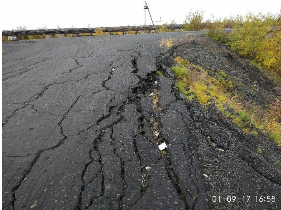
Рис. 7. Сползание откоса и части дороги в термокарстовое озеро при его развитии. Участок дороги в аэропорт «Валёк»
