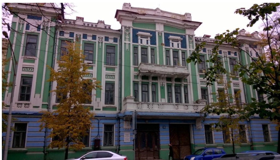
Рис. 1. Текущее состояние главного фасада здания
