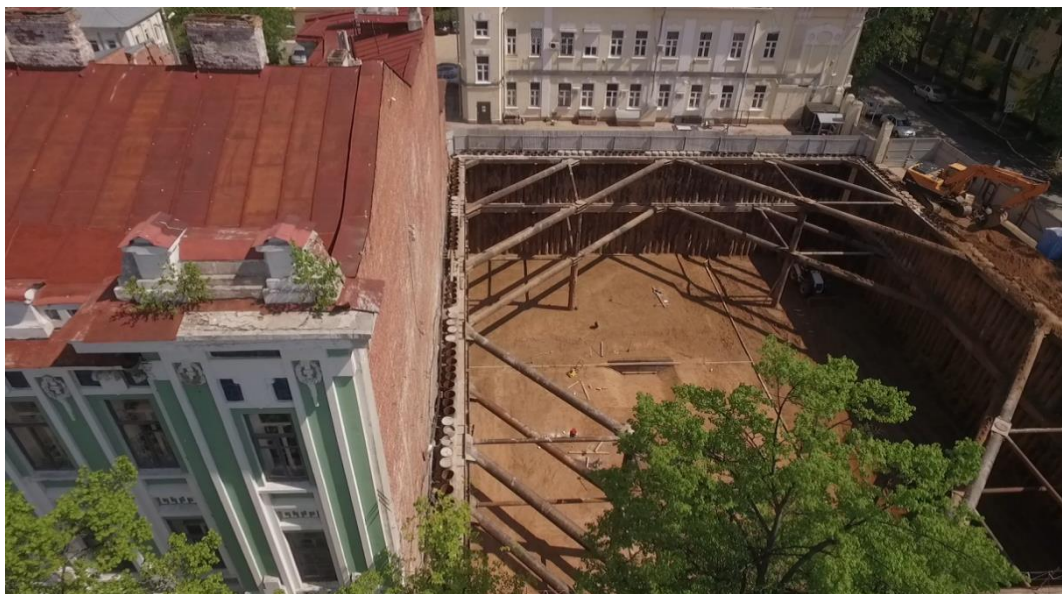
Рис. 3. Вид прилегающих объектов котлован нового здания
