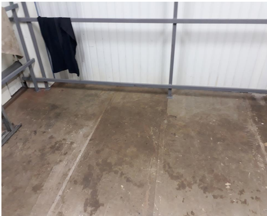
Рис. 2. Подтопление домов, прилегающих к участку засыпки
