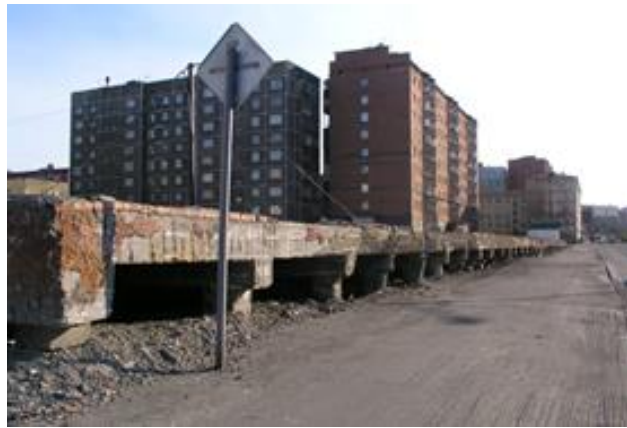
Рис. 7. Ростверки снесённых 9-ти этажных жилых домов, г. Норильск, 2017 г. Фото В. Гребенца
