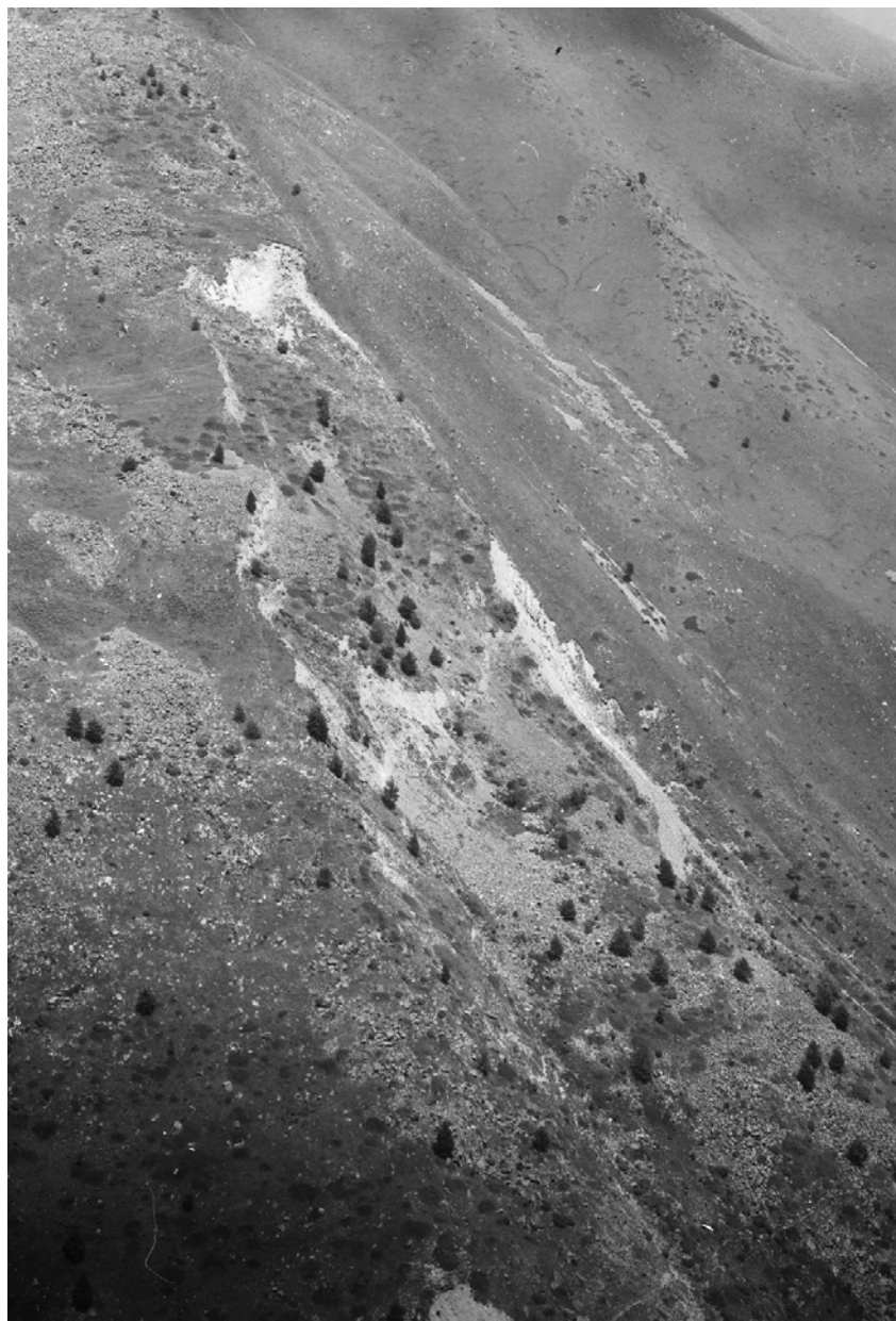
Рис. 5.8. Оползень на левобережном склоне долины р. Кубасанты. Фото Е.А. Золотарёва, 1987 г.
