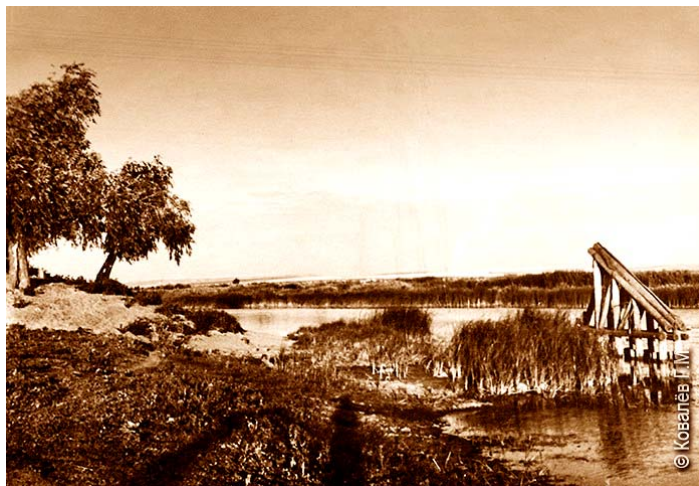
Место, где стоял снесенный ледоставом мост. Фото Ковалева Г.М.
