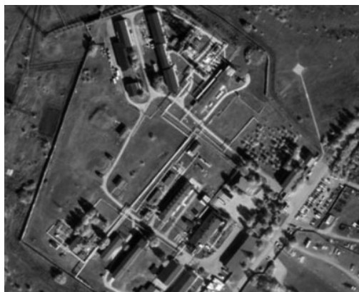
Рис.2. Компрессорная станция «Похвистнево»
