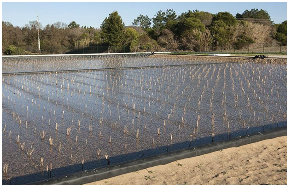
Строительство современного фитоочистного сооружения
