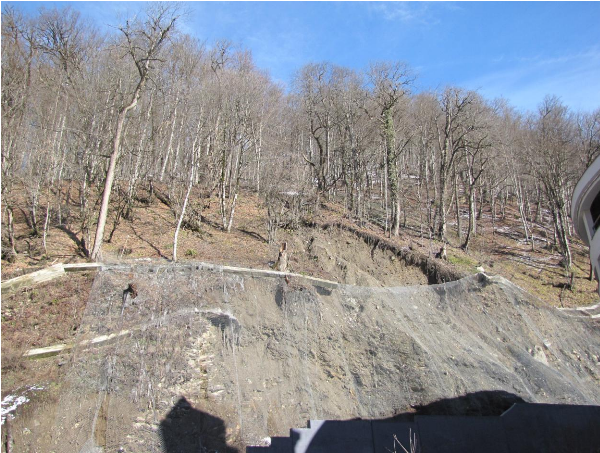
Рис. 6. Оползание подрезанного склона в Роза-Хутор (фото М.Н.Иванова) 2013 г.
