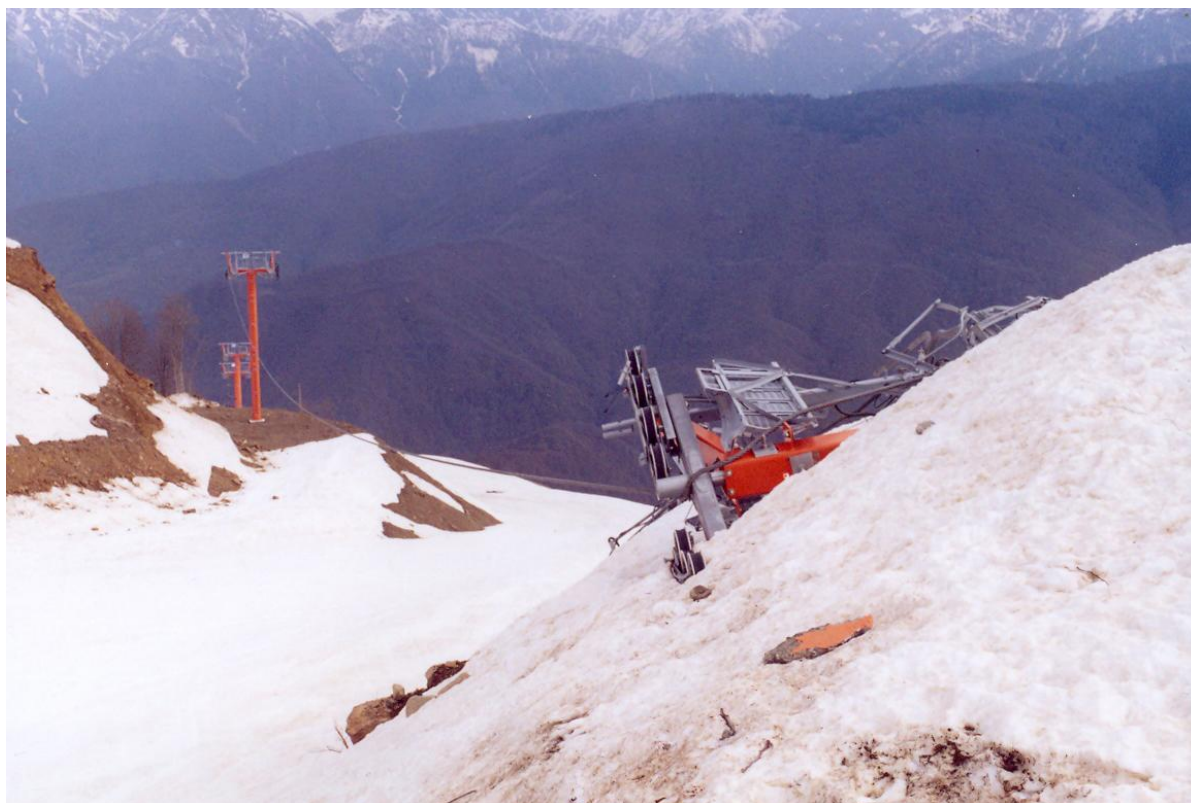
Рис. 4. Канатная дорога Родниковая разрушена лавиной, (фото Л.А. Андреева) 2006 г.
