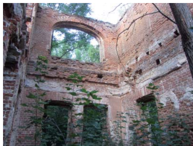
Рис. 3. Усадебный дом. Современное состояние.
