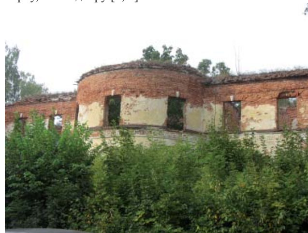
Рис. 2. Усадебный дом. Современное состояние.
