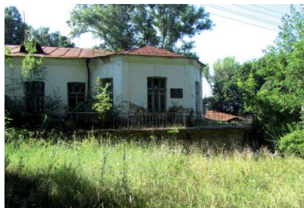
Рис. 5. Усадебный дом с террасой на цоколе.
