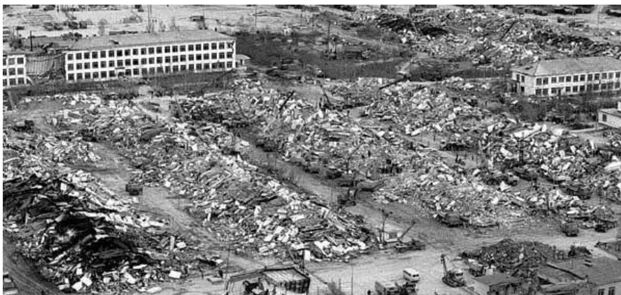
Рис. 3. Полностью уничтоженные землетрясением жилые дома п. Нефтегорск
