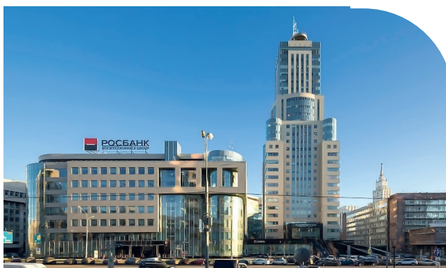
▲ Здание ПАО «Росбанк» с энергоэффективным остеклением атриума и фасада
