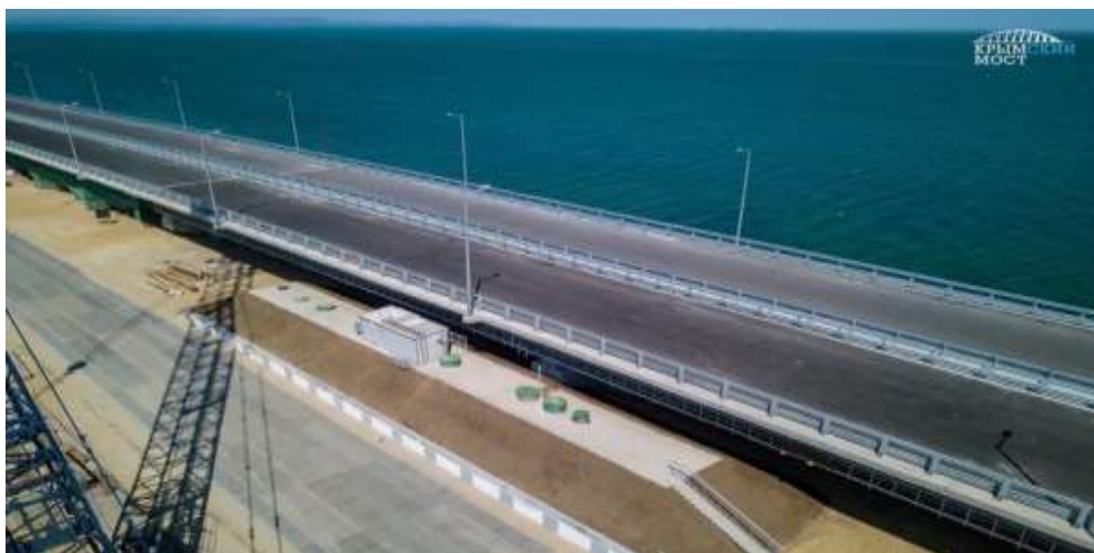
Рис. Ливневые очистительные сооружения Керченского моста
