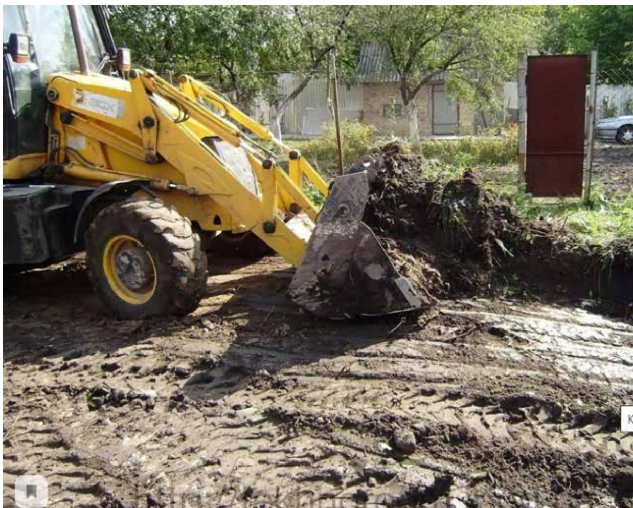
Рис. 3. Снятие гумусового горизонта почв и трансформация его в плодородный слой
