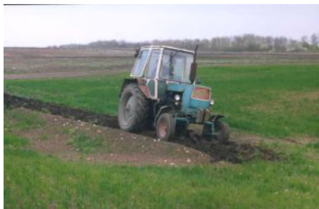
Рис. 2. Припашка наносов в тело противоэрозионного вала-перемычки в ложбине стока (с.-х. предприятие «Ударник», фото Зубова А.Р.).
