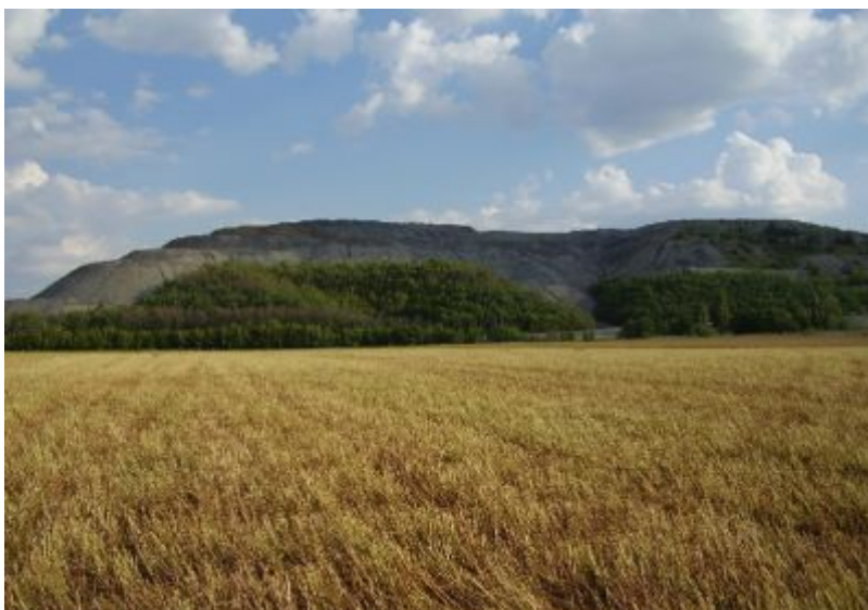
Рис. 4. Внешний вид отвала, защитных лесонасаждений и прилегающих агроландшафтов
