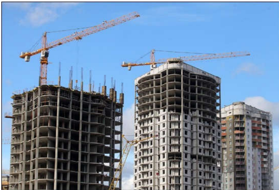
Рис. 1 – Процесс строительства железобетонного каркаса здания
