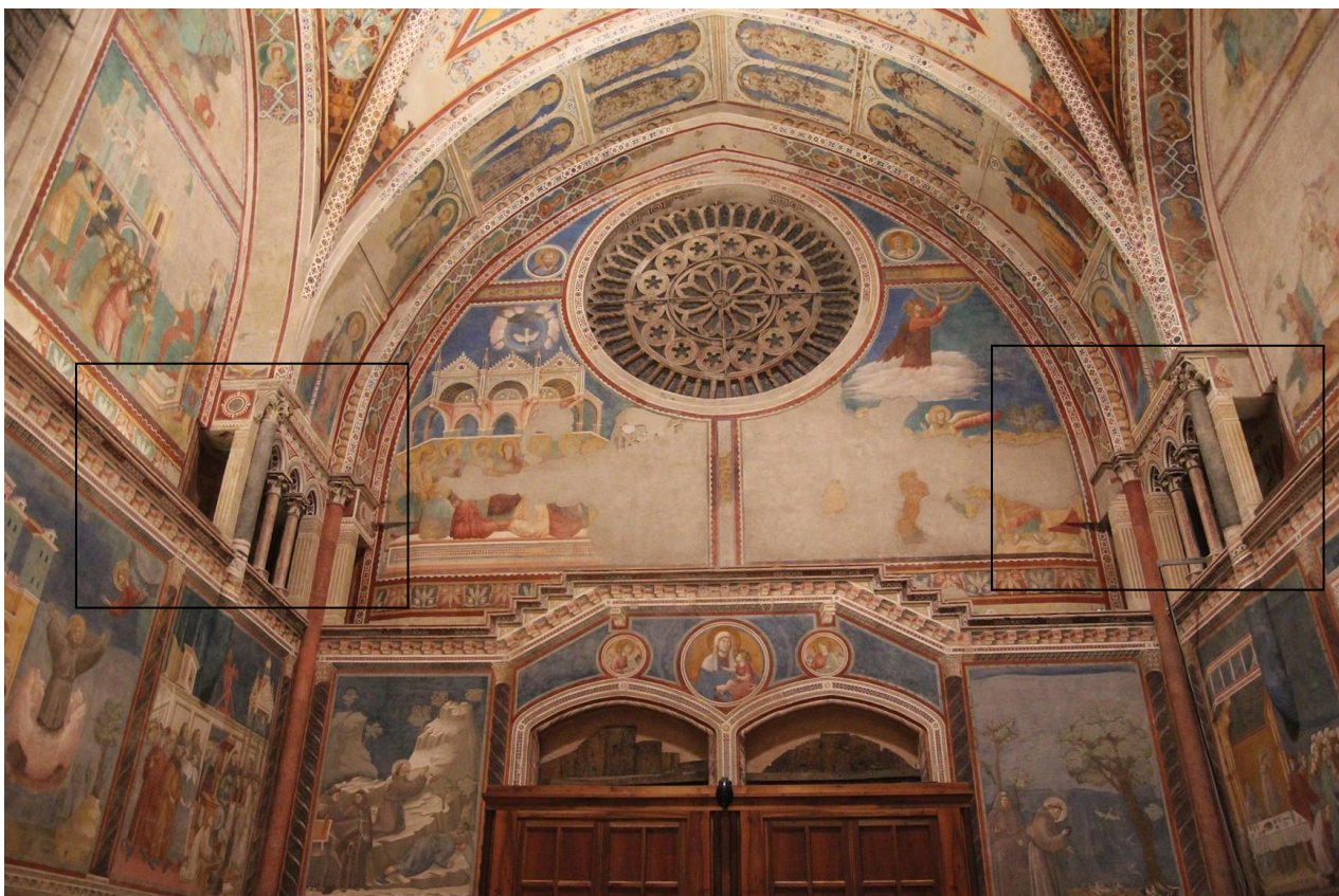
23. Ассизи. Сан Франческо. Верхняя церковь. Вид на западную стену и passage rémois.
