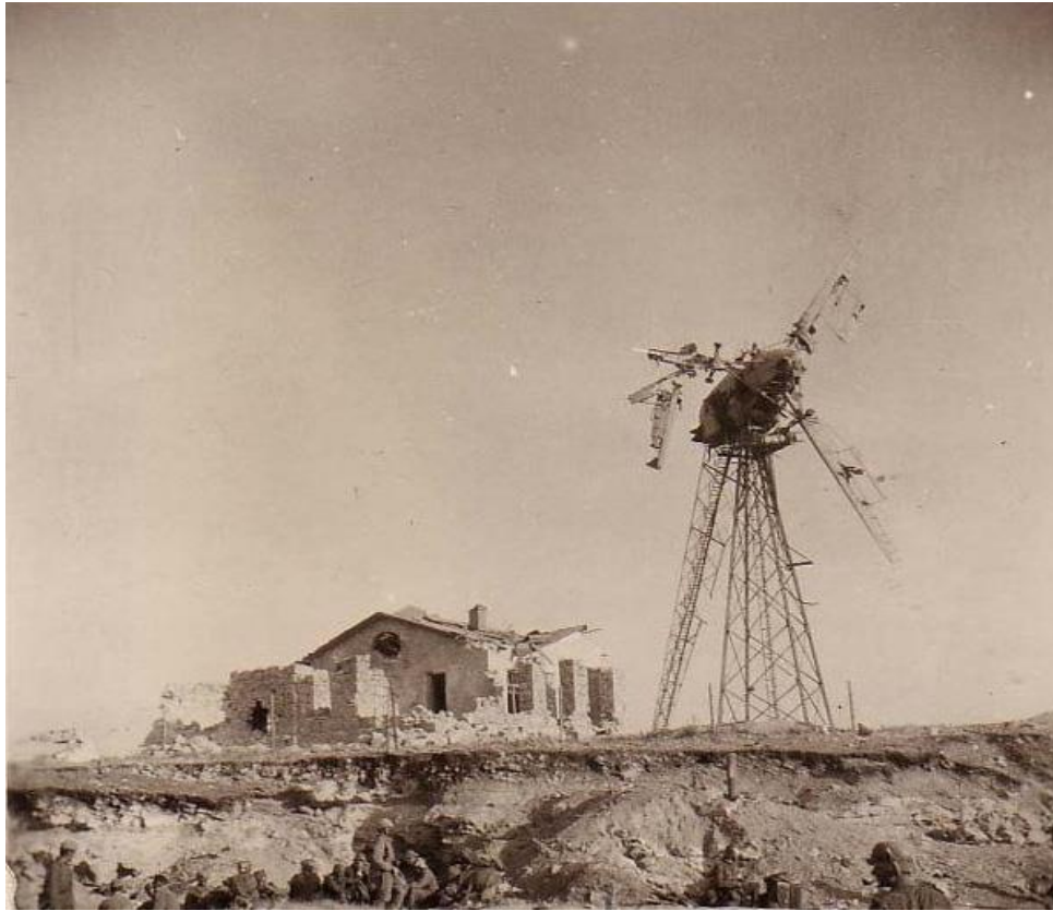
ВЭС в Балаклаве, 1931. Мощность 100 кВт, диаметр колеса 30 метров
