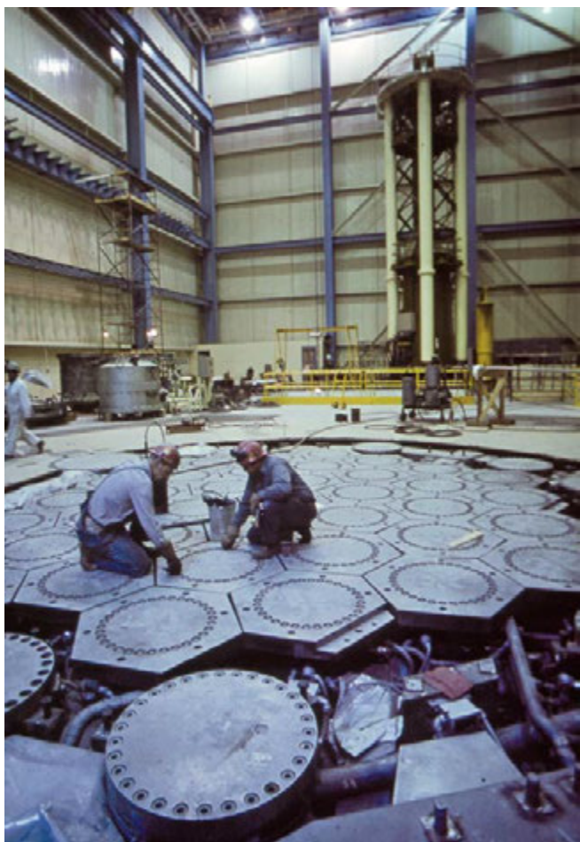
Укладка топливных элементов на АЭС Fort St. Vrain
