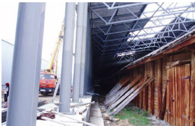
Возведение защитного ангара над обветшавшим хранилищем монацитового концентрата (Источник: www.monazit.ru )
