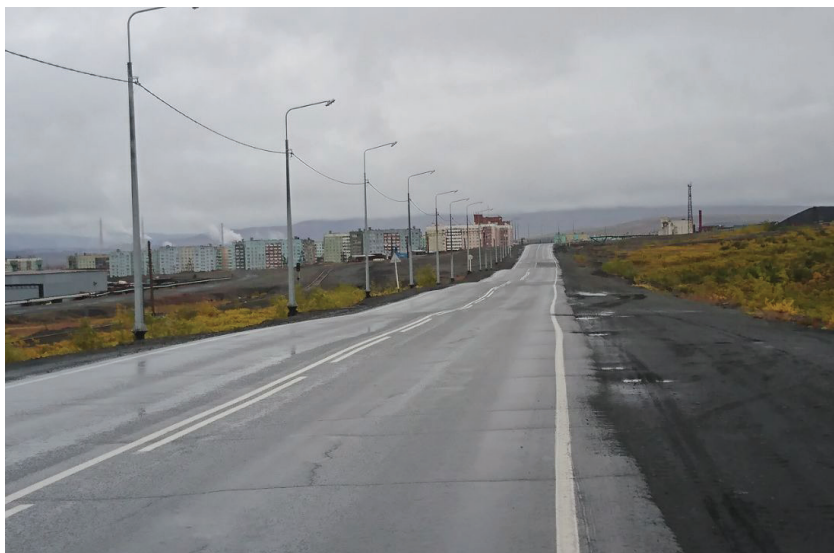
Рис. 1.2.7. Волнообразные равномерно распределённые деформации полотна трассы «Норильск — Алыкель» при вытаивании повторно-жильных льдов, объезд г. Кайеркана. 5.09.2017. Фото В. Гребенца
