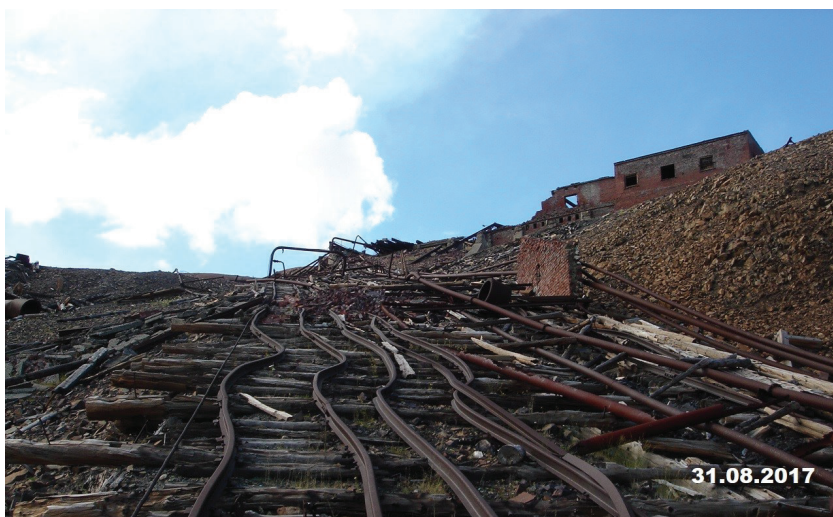
Рис. 1.2.6. Деформация железнодорожного полотна при смещении обломочного льдосодержащего грунта (север Красноярского края, Норильский промрайон). Фото В. Гребенца
