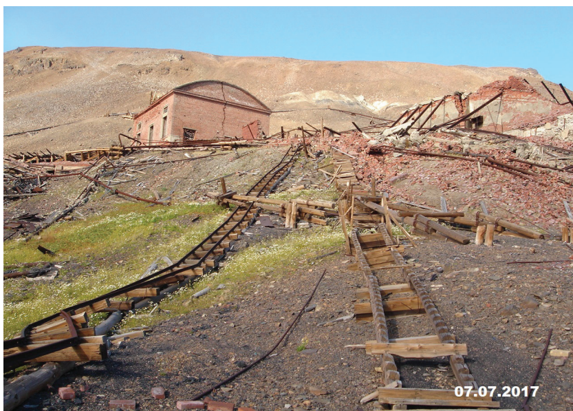
Рис. 1.2.5. Разрушение путей для вагонеток на горе Шмидта (север Красноярского края, Норильский промрайон). Фото М. Иванова
