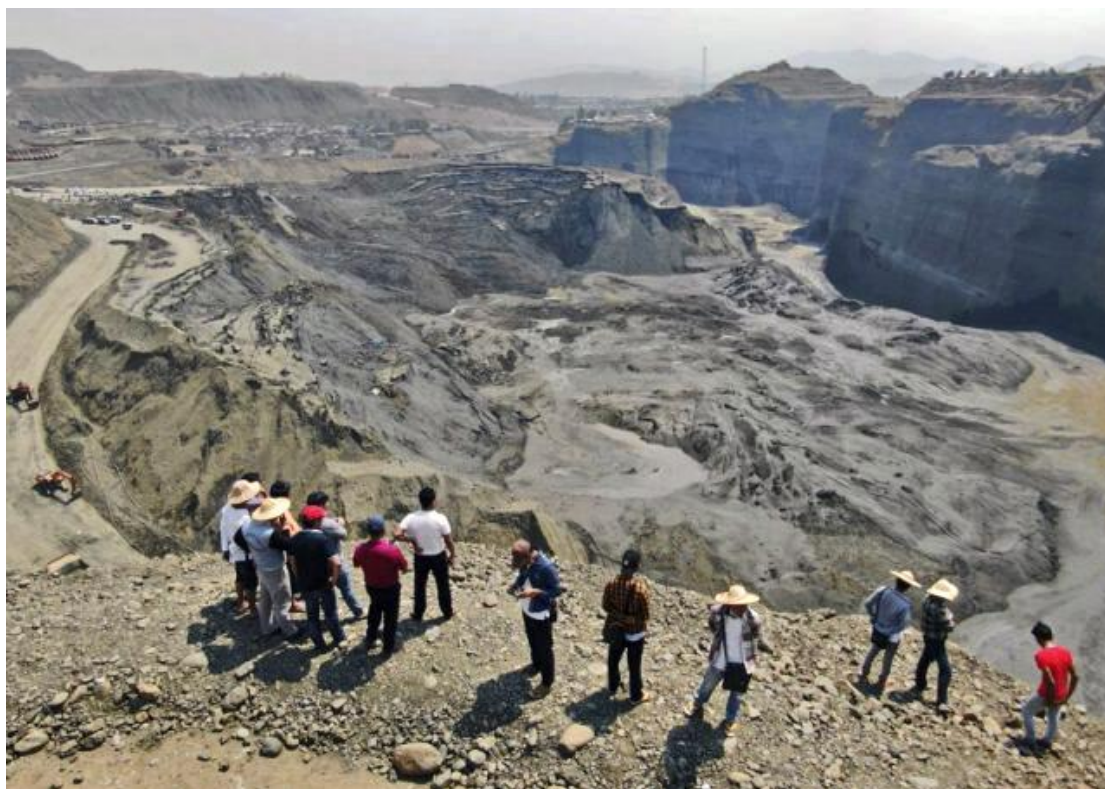
Рис. 13. Качин. Мьянма. 23 апреля 2019 г. Селевые отложения в нижнем бьефе прорванной дамбы хвостохранилища, накрывшей выработки нефритового месторождения. Image from Zaw Moe Htat via AP and Pressfrom.info. https://blogs.agu.org/landslideblog/2019/04/25/balakh-village-1/
