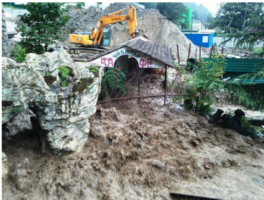
Рис. 1. Селевой поток р. Ржаная (лев. приток р. Мзымта), возникший в результате складирования грунта на пойме, повреждает объект общественного питания. Август 2012 г. Фото Котенко Г.Э.
