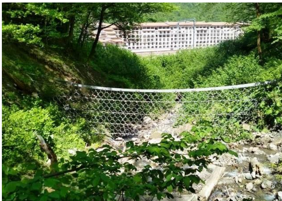
Рис. 2. Противоселевой барьер на ручье Мостовой (лев. приток р. Мзымта) выше железной дороги. Фото Самаркина-Джарского К.Г.
