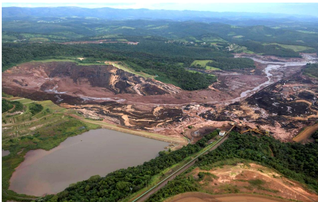
Рис. 6. Фейхао. Бразилия. 28 марта 2019 г. Вертолетный снимок участка нижнего бьефа разрушенной плотины хвостохранилища и сохранившегося правобережного водоема (спущен после января 2019 г.). Фото Вашингтон Алвес (Reuters)
