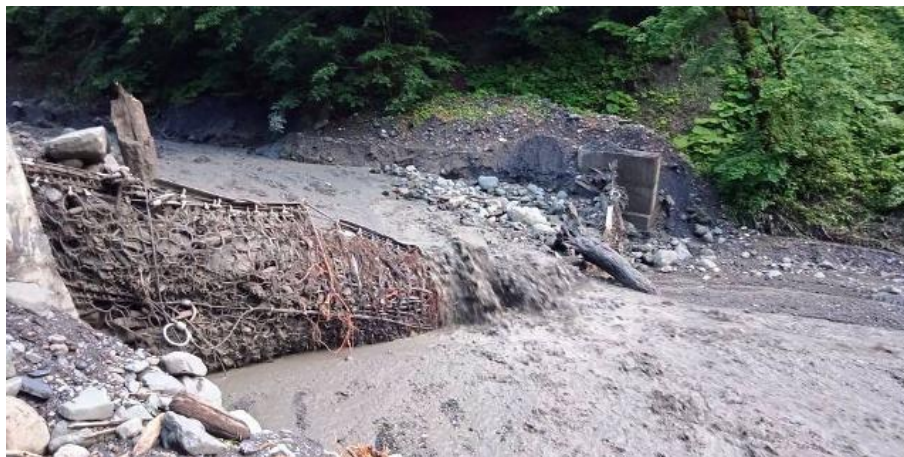
Рис. 3. Противоселевой барьер на реке Сулимовская (лев. приток р.Мзымта) на спаде селевого паводка. 25.06.2019 г. Фото Иськова И.В.
