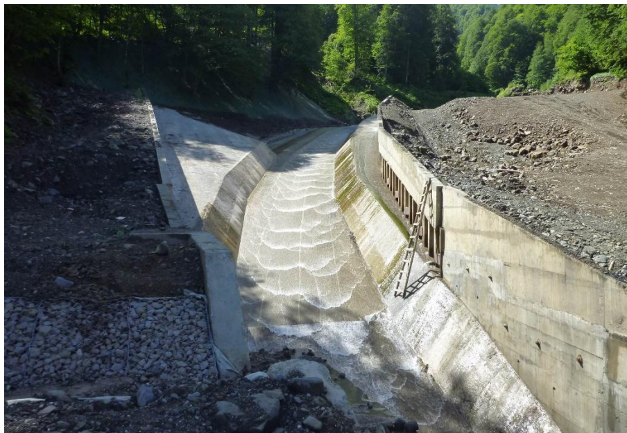
Рис. 5. Селепропуск на ручье Шумихинский (приток реки Ржаная). Фото Е.В. Дзаганиа
