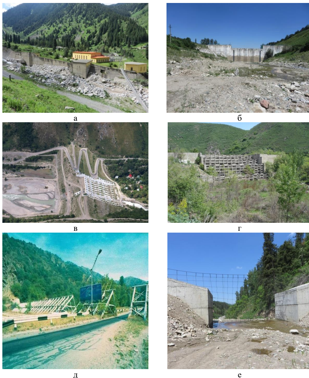
Рис. 2. Селезащитные сооружения в Зайлийском Алатау. а – селенаправляющая железобетонная дамба на р. Улкен Алматы, б – селеостанавливающая сплошная железобетонная дамба на р. Каргалы, в – селеостанавливающая сплошная каменная дамба на р. Талгар, г – селеостанавливающая решетчатая железобетонная дамба на р. Каскелен, д – сквозная решетчатая стальная плотина дамба на р. Киши Алматы, е – селезадерживающий стальной тросово-сетчатый барьер на р. Беделбай
