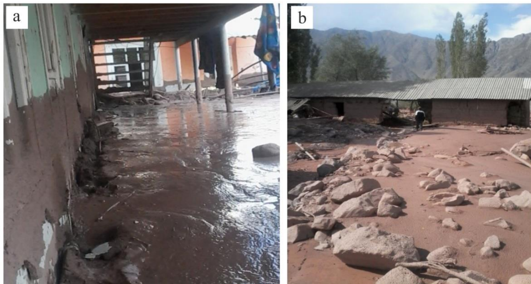
Рис. 6. Грязевая (а) и грязекаменная (б) масса в жилой зоне селений Капали и Фатхобод. Фото Б.А. Сатторова, 31.08.2016
