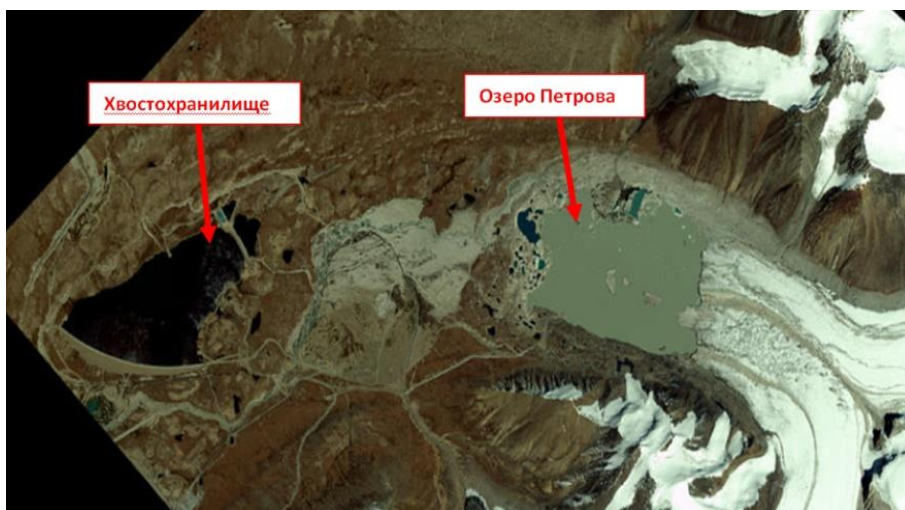
Рис. 14. Оз. Петрова (И-76) и хвостохранилище золотодобывающего рудника Кумтор в 5 км ниже
