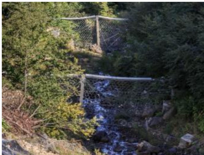
Рис. 3. Каскад из эксплуатируемых гибких селеудерживающих барьеров хорошо вписывается в ландшафт местности
