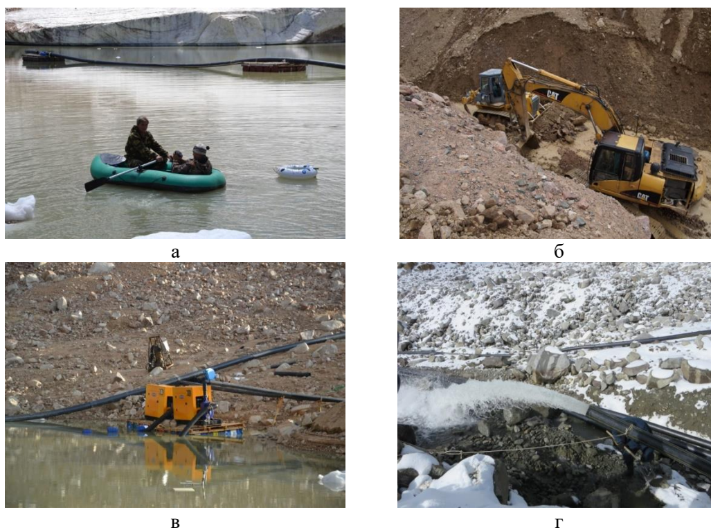
Рис. 1. Работы по превентивному опорожнению моренных озёр. а – батиметрическая съёмка с использованием эхолота и GPS-навигатора, б – прокладка поверхностного канала с использованием экскаватора и бульдозера, в – насос для откачки воды насосами, смонтированными на плавучей платформе, г – сброс воды сифоном
