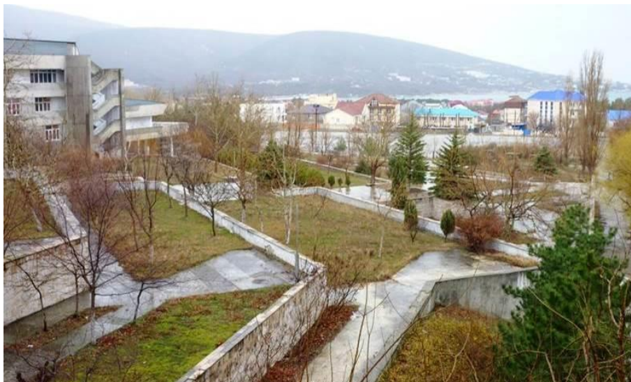
Рис. 7. Комбинированная защита от эрозии в районе Геленджика
