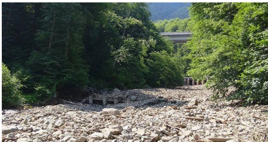
Рис. 4. Вид вверх по течению на два барража на реке Сулимовской в правой части русла после селевого паводка 24.06.2019 г. Фото И.В. Иськова
