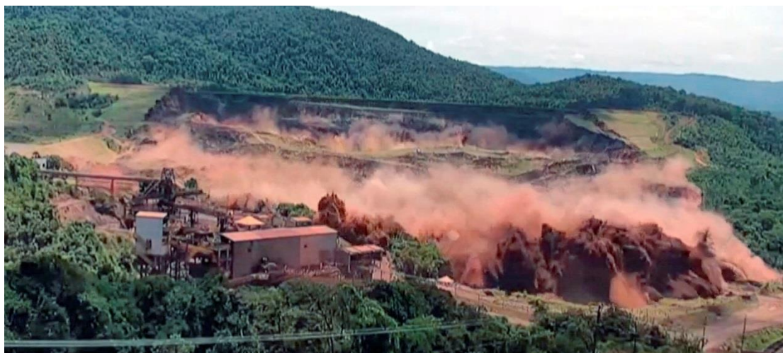
Рис. 5. Фейхао. Бразилия. 25 января 2019 г. Через 20 сек после первых деформаций плотины хвостохранилища. Кадр видеоролика https://www.youtube.com/watch?v=SZ8ma4XOgow
