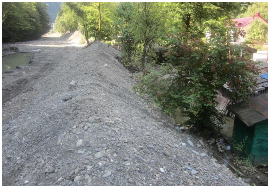
Рис. 6. Правобережная дамба для защиты села Кепша от затопления. Фото В.А. Филиппова
