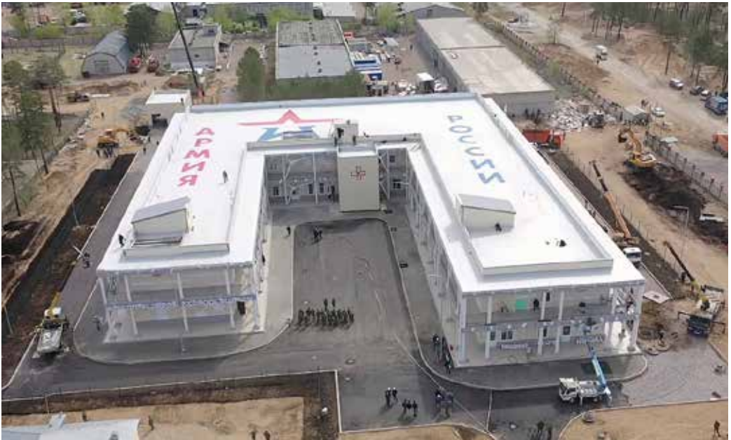
Рис. 7. Строительство нового госпиталя Минобороны России в Абхазии.
