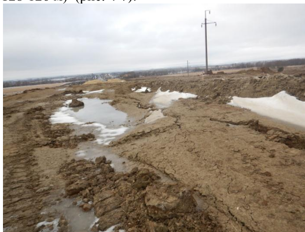
Рис. 4. Северная часть головного блока оползня скольжения. Справа – стенка срыва, слева – при оседании головного блока образовалось озерко при таянии снега
