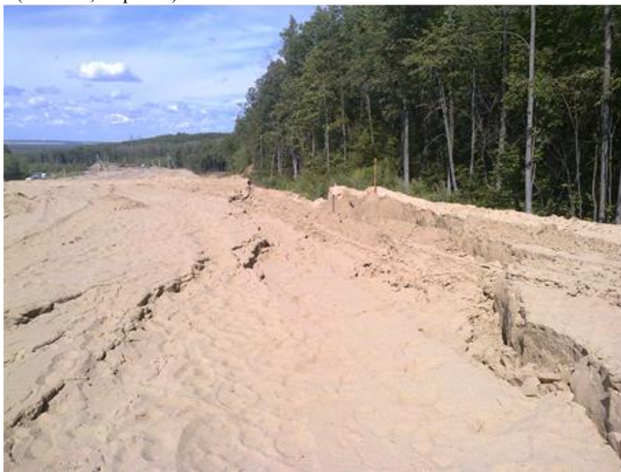
Рис. 2. Головной блок сброса косо пересекает грунтовую насыпь и кювет дороги и переходит на головной блок давнего оползневого яруса.
