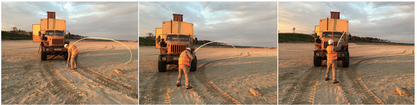
Рис. 6. Установка обсадки из поливинилхлорида в скважину статического зондирования Fig. 6. Pipe installation of PVC into CPT hole
