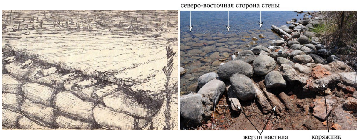
Рис. 5.3.12. Бревенчатый настил на подводной стене, сложенной из окатанных валунов. Зарисовка 1959 г. Д.Ф. Винника [1961].▲
