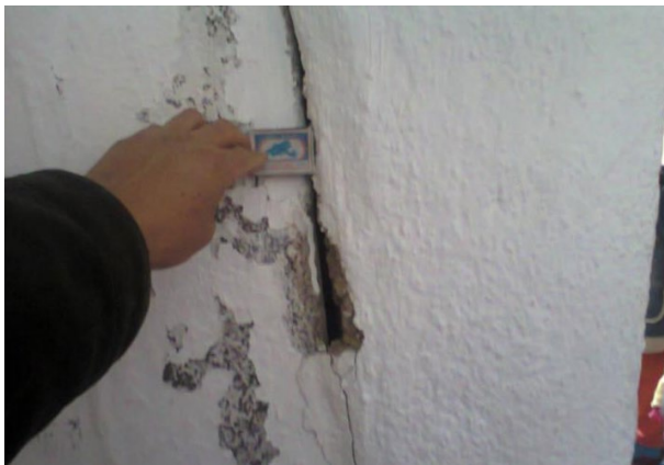
Рис. 5.13.23. Откол части угла дома с образованием трещин. Село Коргон-Булак, ул. Достук 1 (N 42°05'01.5", E 77°14'21.0", alt. 2452 м); хозяин дома К. Балтаев (фото и данные координат Т.А. Чаримова, Ы. Камчыбекова) ▲
