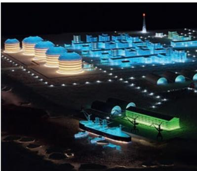
Проект второго завода НОВАТЭКа предусматривает строительство трех очередей по производству СПГ мощностью 6,6 млн т/год каждая на основаниях гравитационного типа.
