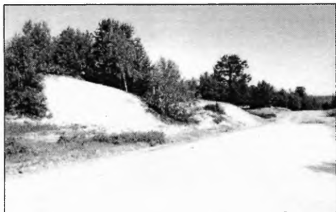
Фот. VII. Безымянная – наступание песчаных массивов на дорогу (фот. Г. И. Овчинникова)
