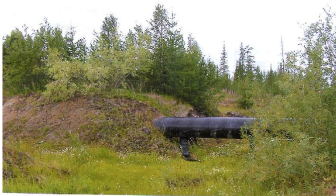
рис. 3. Трубопровод, размытый поперечной термоэрозией (а) и вдоль отвешка оврага (б)
