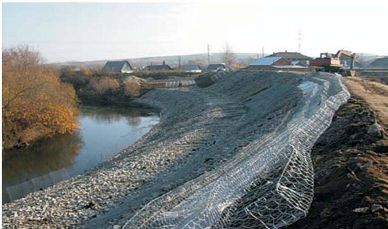
**Рисунок 4** – Габионное укрепление берега р. Шаква (в черте г. Кунгур)
