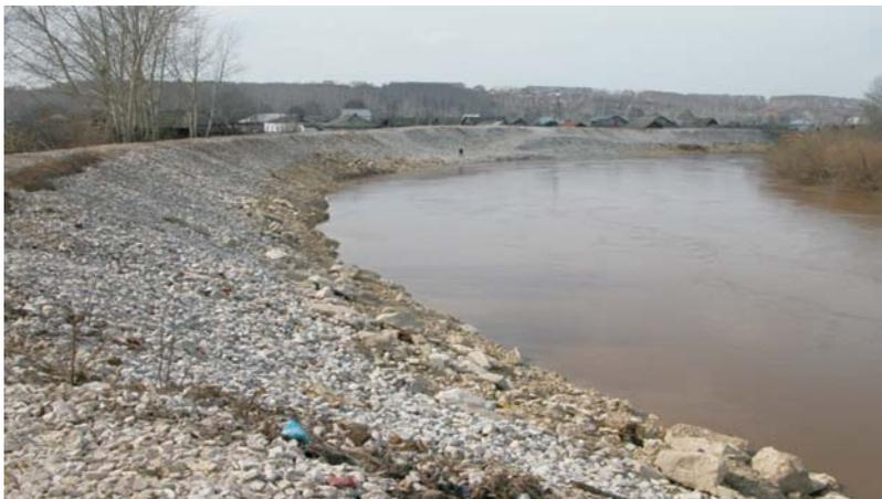
*Рисунок 2 – Каменная наброска. Защитная дамба на р. Ирень (в черте г. Кунгур)*
