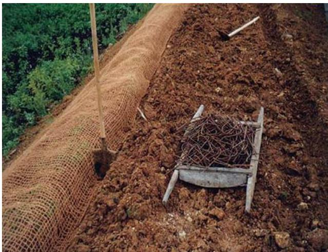
*Рисунок 5 – Биотекстильное закрепление берега р.Сылва
