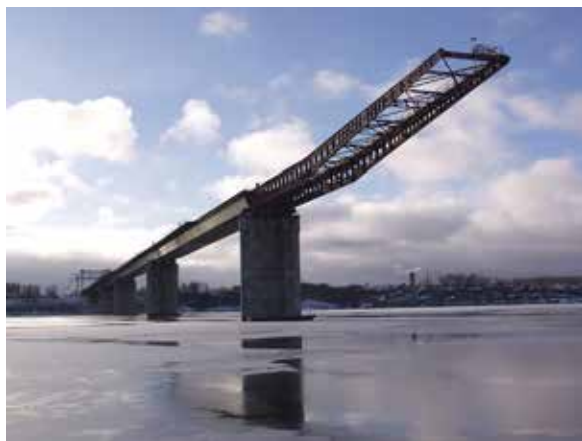
Рисунок 3. Монтаж пролетного строения методом надвигки
