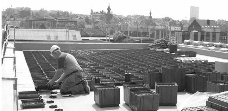
Рисунок 1. Устройство зеленых кровель на регулируемых опорах
