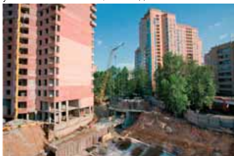
Рис. 1. Общий вид строящегося здания в стесненных условиях
