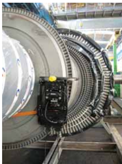
СОЛБЕР Пайп, закрепленный на турбине. Завод по ремонту паровых турбин, Катовице (Польша)
