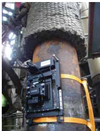
Нефтеперерабатывающая станция Raffineria di Roma, Рим (Италия)
